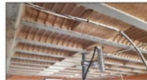
Gestion des SAD (acoustique entre les murs et le plancher) grâce au SEACROS rigide
